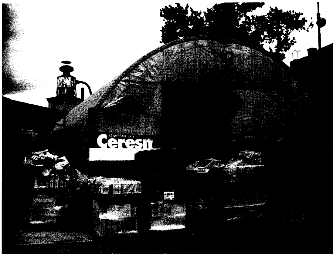
obr. 12 – textilní hala postavená převážně na cizím pozemku
