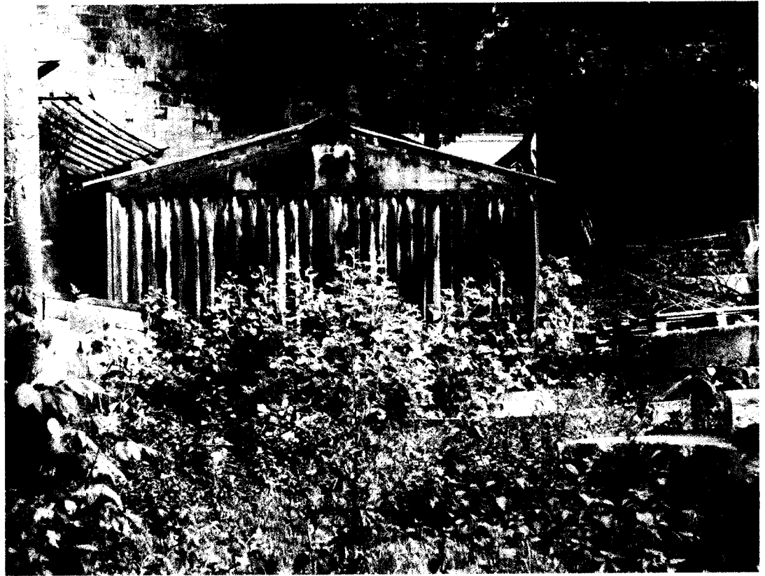
obr. 15 – plechový sklad na cizím pozemku, dezolátní stav
