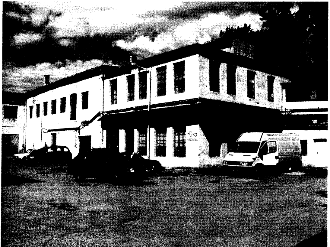
obr. 4 – pohled na skladovací budovu č. 4 a č.5
